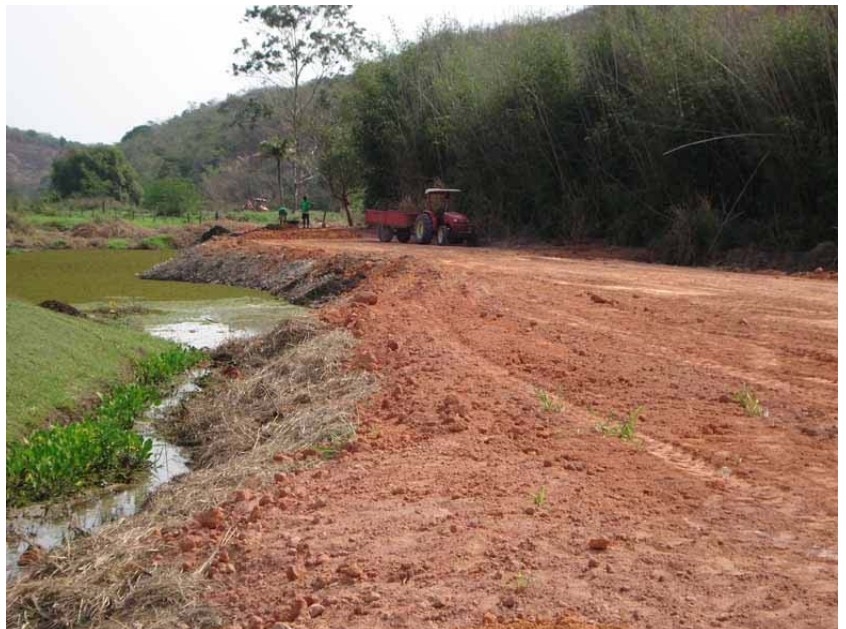
Construção do novo tee do buraco 6
